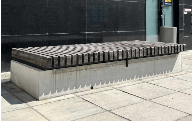
Jakotukkipenkki, koko vaihtelee istuintason alle jäävän jakotukkitilan mukaan, toteutetaan Kulttuuriraitin jakotukkipenkkiä suunnitelmien mukaisesti, istuintason materiaalina käsittelemätön lehtikuusi. (Sitowise)
