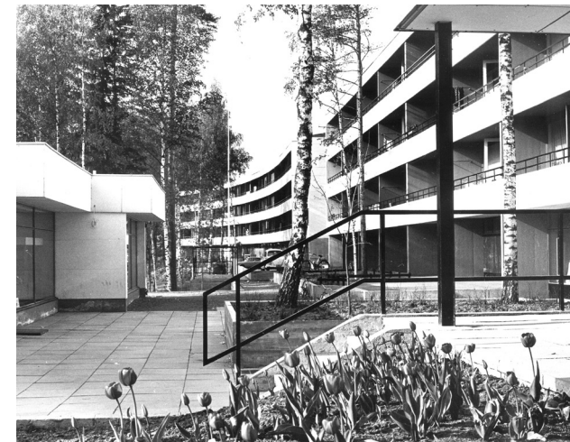
Itärannan ostokeskuksen laatoitusta ja metallikaide. (Asuntosäätiön arkisto)
