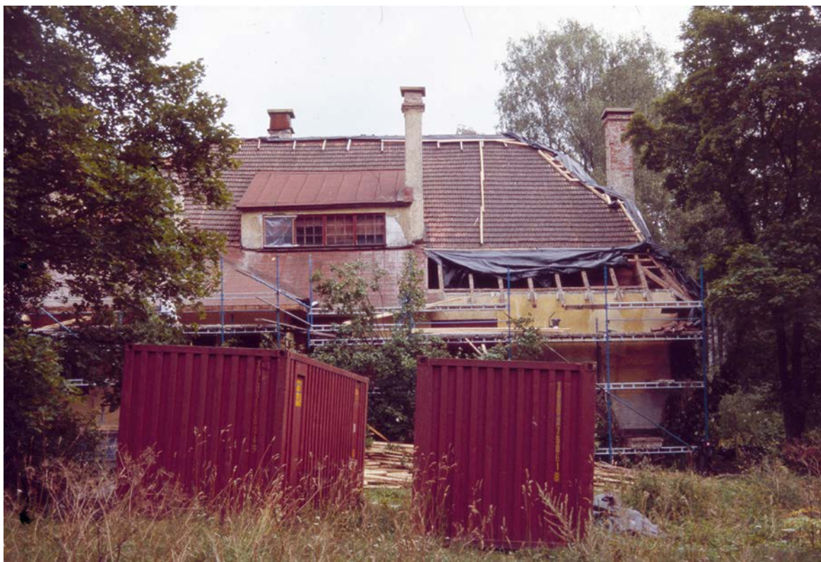
Villa Elfvikin kattoremontti käynnissä kesällä 1986. KAMU Espoo
