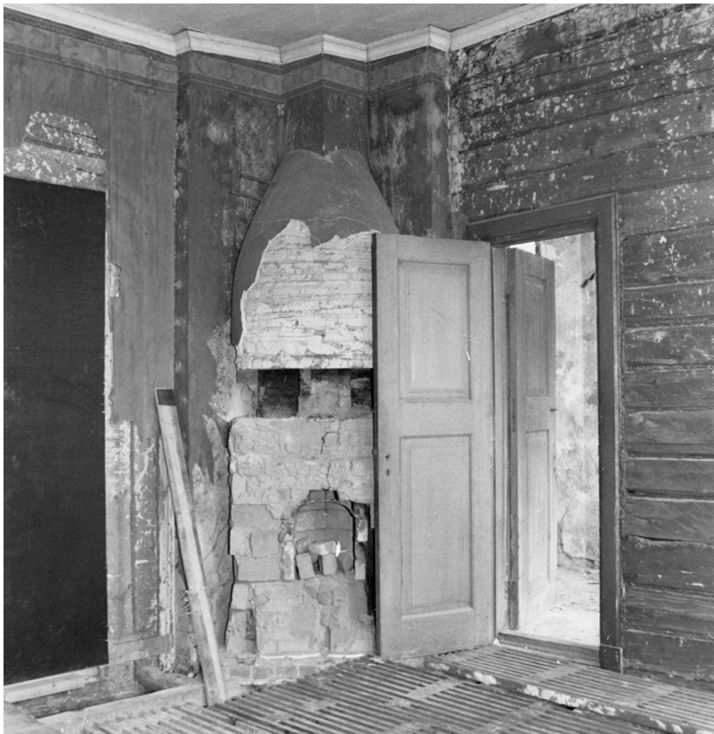
Peruskorjaus käynnissä. Turkkilaisen huoneen kaakeliuuni odottaa uudelleen kokoamista. KAMU Espoo
