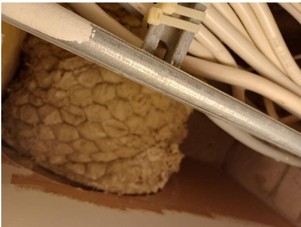
Kuva 4.11. 220 Tekniikkatila, pinnoittamatonta mineraalivillaa näkyvissä.
