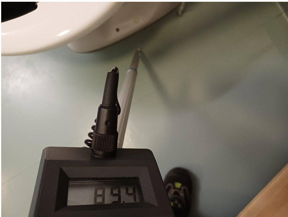
Kuva 4.6. 133 LE-WC, lattiasta mitattiin pintakosteudenosoittimella hieman kohonneita arvoja wc-pöntön ympäristössä.
