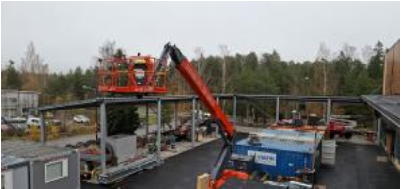
Kuva 11A.3. Konttivarasto rakennusvaiheessa.
